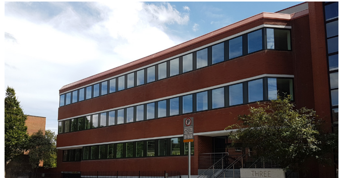
Bürogebäude „Three Haddington Buildings“, Dublin, Irland
